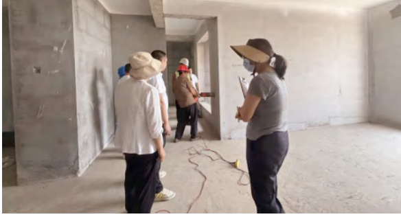
4月29日，湖北金港汽车公园项目甲、乙方工程人员对内墙保温进行现场勘查（王焱 摄）
