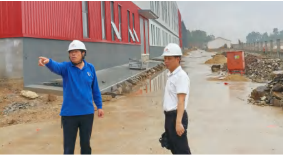
建筑事业部主要管理人员在红安县泛家居产业园项目现场督办工程进度（樊进军 摄）
